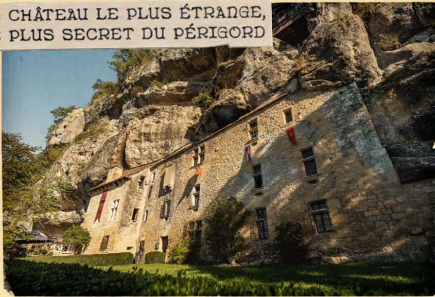
TURSAC - Reignac, en partie creusé dans le roc - XIVe siècle.
